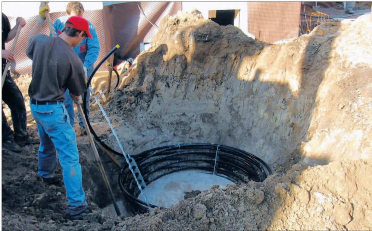
Ein so genannter Erdwärmekorb bringt die Wärme aus der Erde ins Wohnzimmer. Er muss „eingeschlämmt“ werden, wie hier im Fronhof, da Luft-räume sonst den Wärmenachschub behindern würden.
